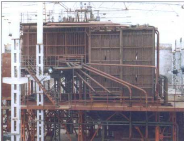
Рис. 3. Общий вид котла KE-25-14-250 ФКС при монтаже.
