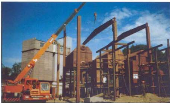
Рис. 2. Монтаж оборудования котельной ОАО «Амурагроцентр».
